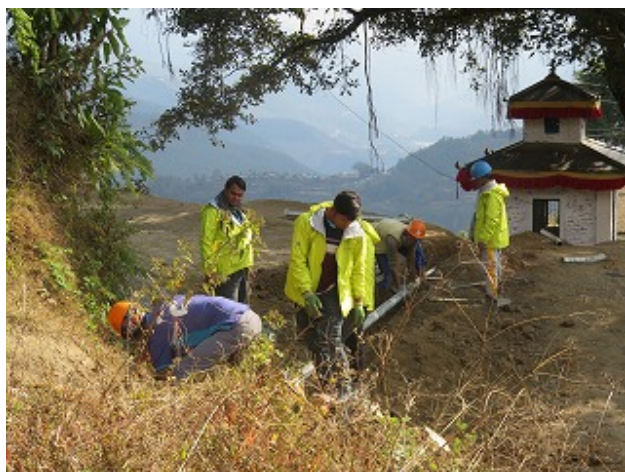
揚水システム設置のためにパイプを設置するエンジニアや現地作業員(ネパール)
