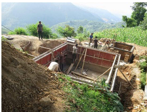
大規模パイプライン 送水用タンクの設置工事の様子(ネパール)
