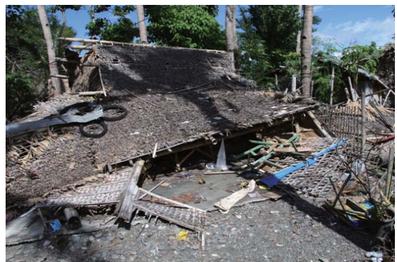
台風により全壊した家
