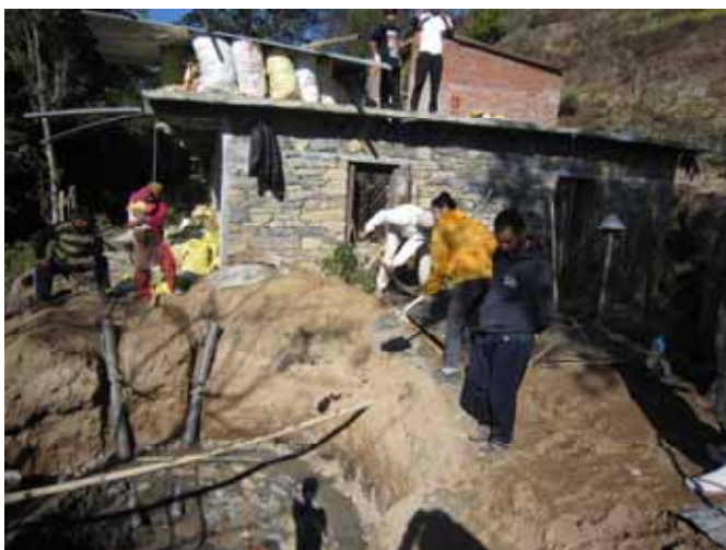
ネパール、バイオガスプラント建設ワークキャンプ
