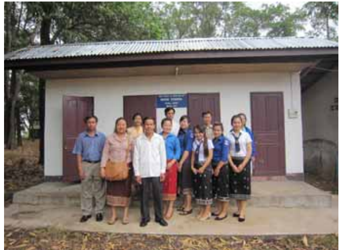
ラオスの職業訓練学校に建設されたトイレ
