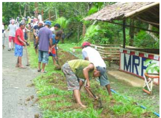
フィリピンのピラク町にてパイプライン建設の作業中
