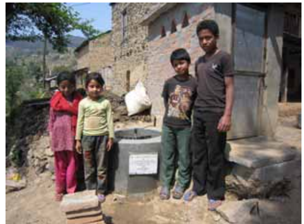
ネパール・バイオガスプラント建設 バグマティ県
