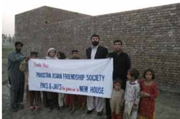
水害復興支援により建設されたシェルター
