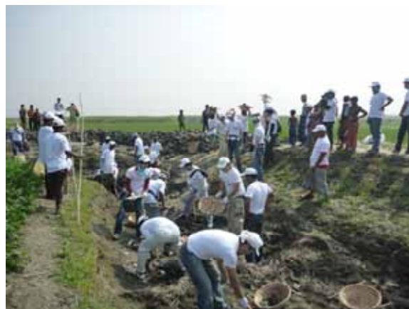
バングラデシュ・道路補修作業の様子 ムンシガンジ県ディキルパル地区ダンコラ村
