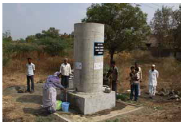
完成した電動式汲み上げ井戸 (インド)
