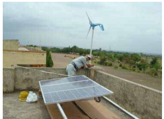
ハイブリット発電を設置しているところ （インド、カルナータカ州ビジャプール地区）
