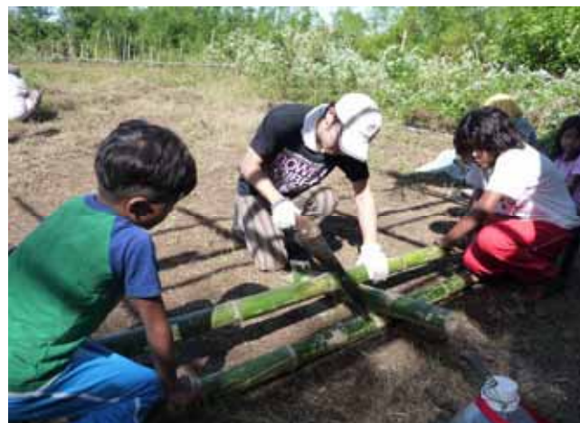
ワークキャンプで女性の農業センターを建設 (フィリピン・リサール州タリム島)
