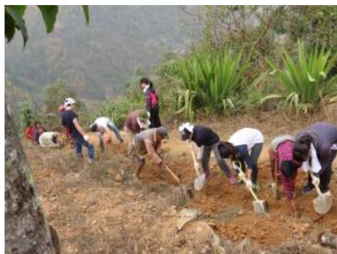
水道パイプライン設置工事の穴掘りする参加者たち(ネパール)
