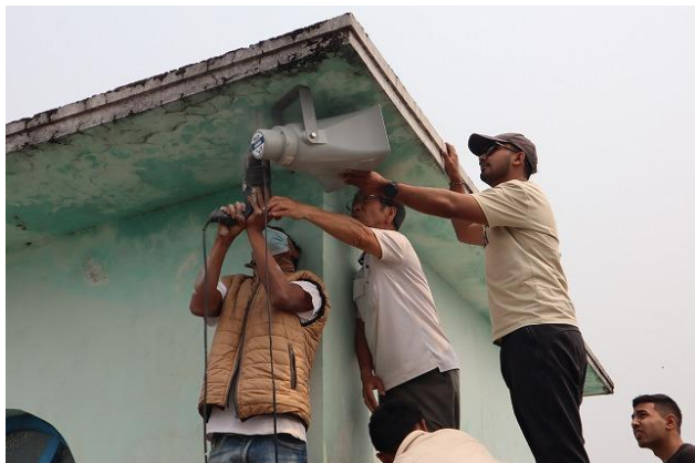
ネパール 地域防災用放送スピーカー設置を指導する畑中専門家
