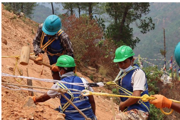
ネパール 斜面崩壊箇所の山腹工事により地域防災を行う
