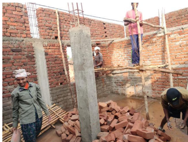
インド ムスカ村で建設が進む新病院
