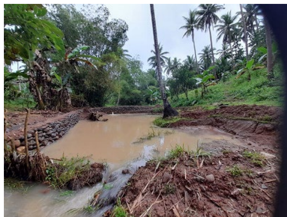
フィリピン 建設中の養殖池
