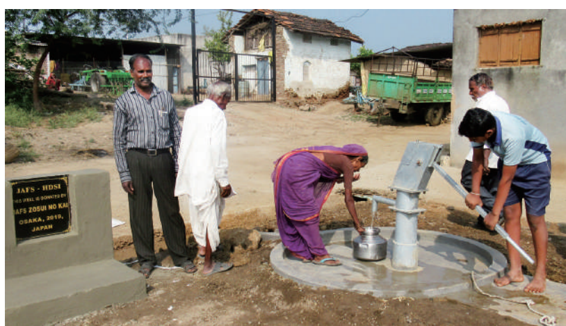
マハラシュトラ州アムラワティ県モーシ地区ウドヘド村 井戸形式: ポンプ式
