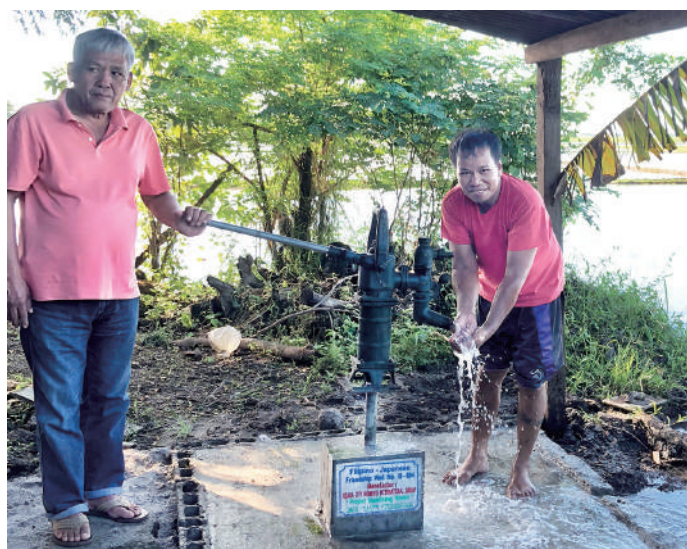
ヌエバエシハ州カピアオ町サンフェルナンドスール村 受益者70名(10世帯) 井戸形式…ポンプ式(深さ31m)
