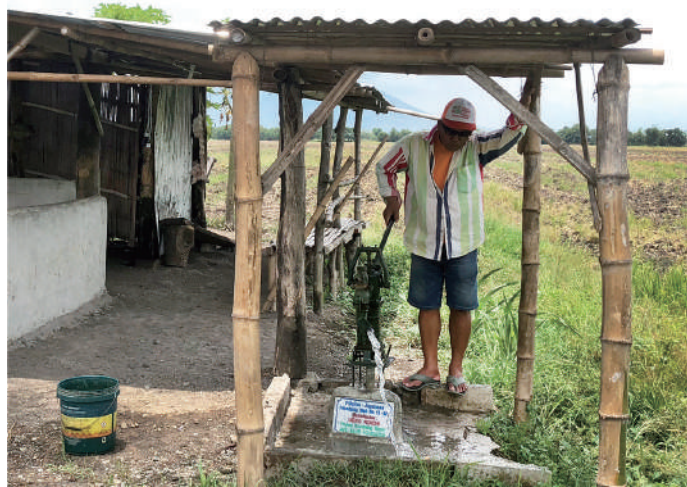
ヌエバエシハ州カピアオ町サンフェルナンドスール村 受益者70名(10世帯) 井戸形式…ポンプ式(深さ30m)
