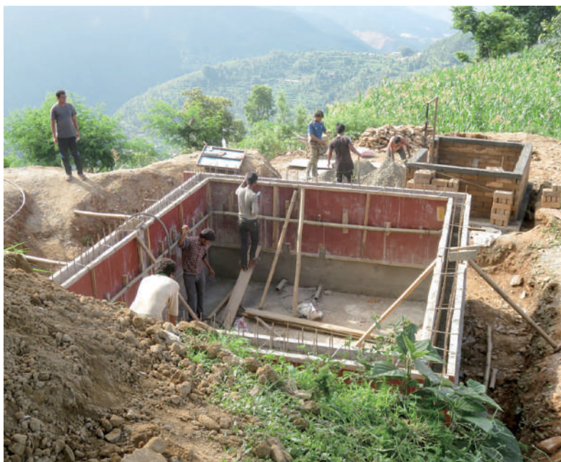
ネパールで谷あいの川から揚水した水を配水するための大規模パイプライン建設。送水用タンクの設置工事中
