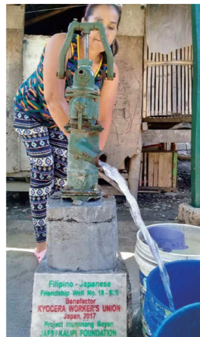
サンタローザ町サブサブ村 受益者：90名（20世帯） 井戸形式：ポンプ式（深さ30m）
