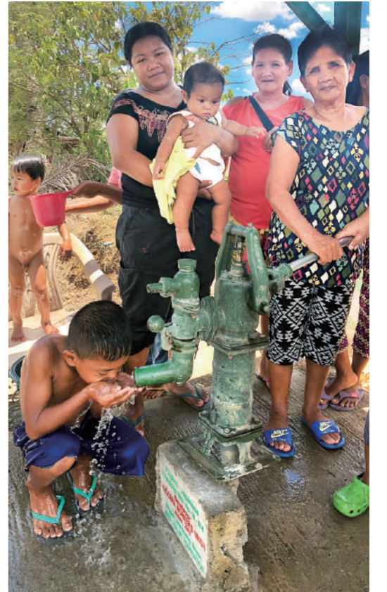
サンタローザ町ソレダット村 受益者：70名（15世帯） 井戸形式：ポンプ式（深さ30m）
