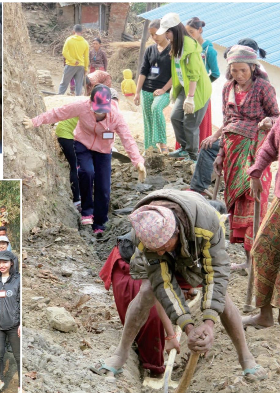
ボランティアと村民が協力し、パイプを埋めるみぞを掘る
