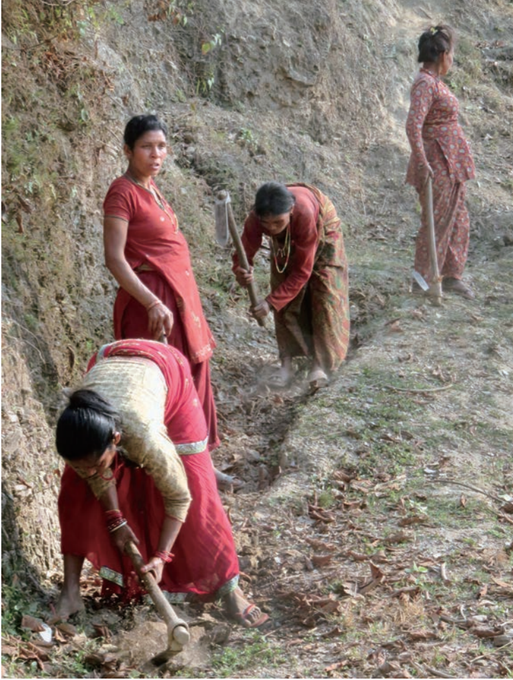
水道パイプライン工事の共同作業にも女性も参加＝2月22日、ネパール・ボテシパ村
