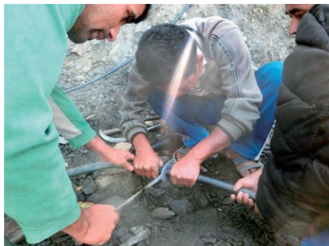
パイプを慎重につないで埋め込む
