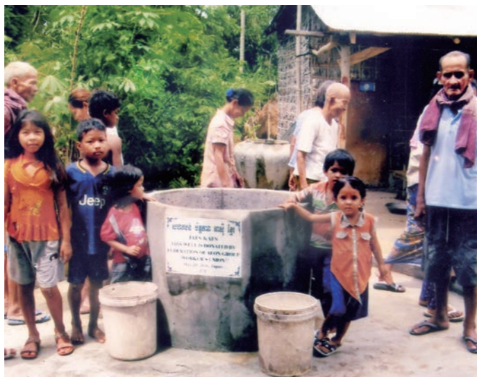
タケオ州トレアン郡トラペアン・トム村 受益者：31名（7世帯） 井戸の形式：露天式井戸（深さ20m）
