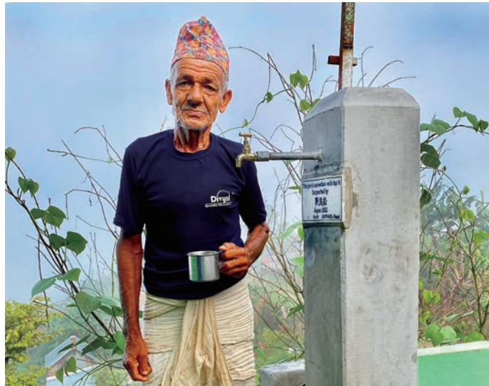
バグマティ州シンドウパルチョーク郡ボテシパ村 受益者…6世帯 井戸の形式…水道パイプライン式
