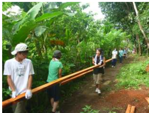
学校の屋根の修繕ワークキャンプ(フィリピンにて) (京都暁星高等学校フィリピンワークにて)
