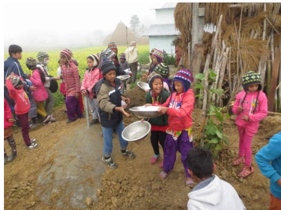
ネパール ワークキャンプ 子どもたちによるバイオガスプラント建設作業
