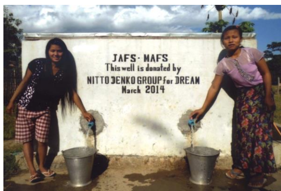
ミャンマーにて完成した給水タンク式井戸
