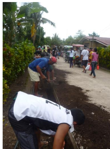
情報労連東海ブロック協議会フィリピンワークキャンプ (村の人たちと共にパイプライン設置作業)
