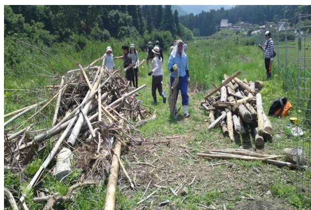
都洪水被害による流木やゴミの撤去作業
